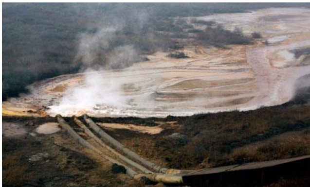
Photo 3 : ci-dessus, l'entreposage peu orthodoxe des résidus des fourneaux d'une usine de transformation des terres rares, Baotou, Chine.
